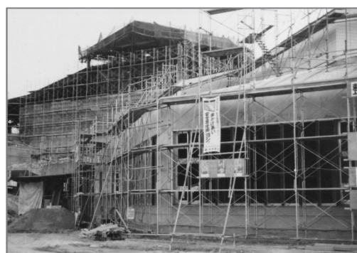
建設中の小郡市民ふれあい広場
